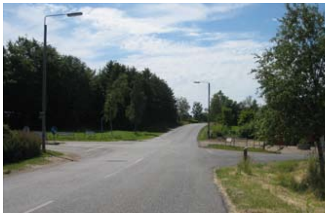
Krydset ved Fynslund, hvor der ønskes etableret en rundkørsel.
