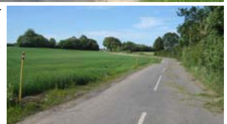
Flere af områdets veje er i dårlig stand med bløde rabatter og slidte kanter. Th. er dette markeret med gule pæle og ovenfor et eksempel på 'lappeløsninger'.
