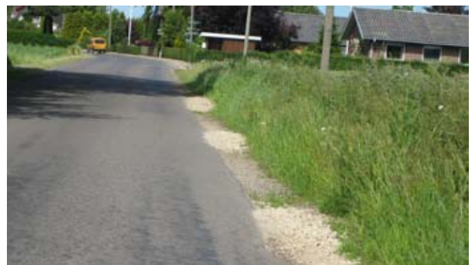
Flere af områdets veje er i dårlig stand med bløde rabatter og slidte kanter. Th. er dette markeret med gule pæle og ovenfor et eksempel på 'lappeløsninger'.
